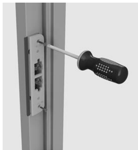
Figur 3 - Montering av slutbleck
