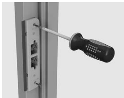
Figur 3 - Montering av sluttstykke
